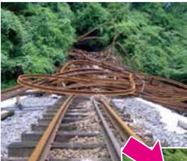
トンネルに流れ込んだ雨水で押し出されたレール(上)。線路の基礎部分を強化するなどして今度の復旧を迎えました。
