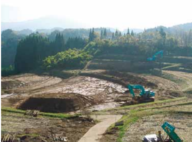
10月に安全祈願祭を執り行った次倉の竹田南部中央工区。ここはもちろんのこと、これから予定の竹田東部地区も予算がなければ事業が進みません。
