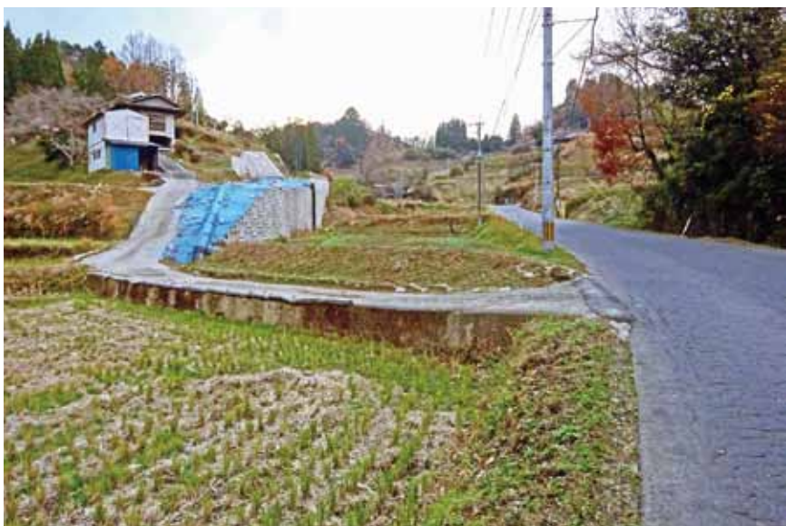
地域の地元業者の力で、地域の社会資本整備が進みます。(県道直入竹田線植木工区)
