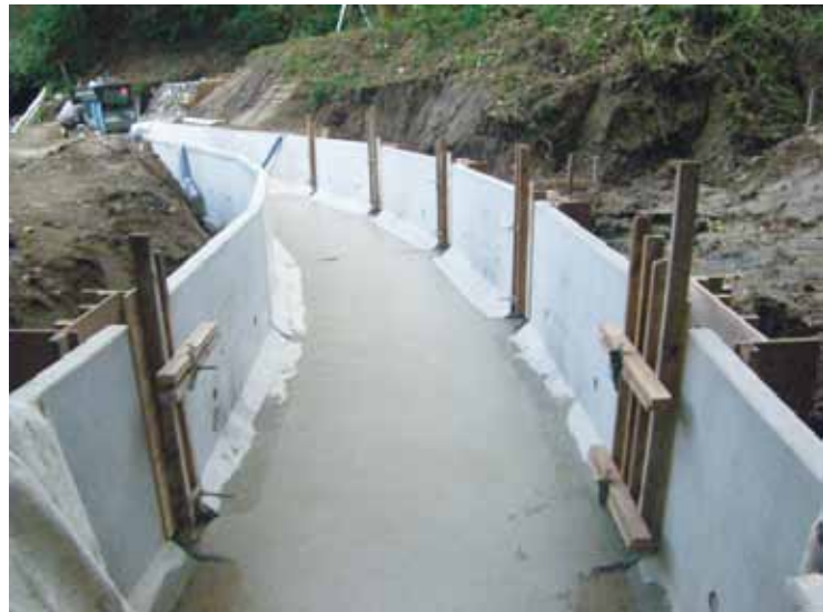
農業水利施設保全合理化作業を実施している竹田市炭竈の刈小野地区。井路の改修などは、地域からの要望が多い。
