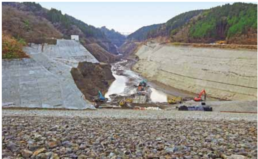
ダムの落水が終わり、湖内の堆積土撤去工事に入った大蘇ダム。現在、平成24年度の豪雨水害でたまった泥などを抜く作業をしています。(12月16日)
