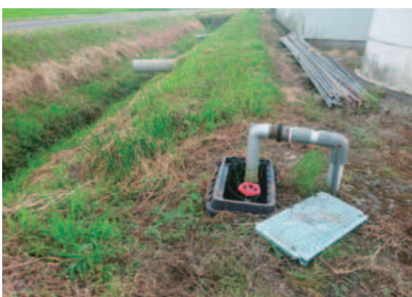
パイプラインで送られてくる大蘇ダムの用水は、給水栓を開けると噴き出てきます。田平会長のところは液肥混入器、タイマーを設置することで、自動的に施肥とかん水を行っています。
