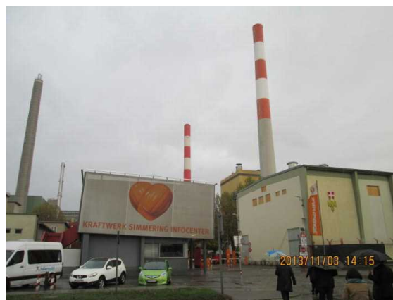
シマリングバイオマス発電所
