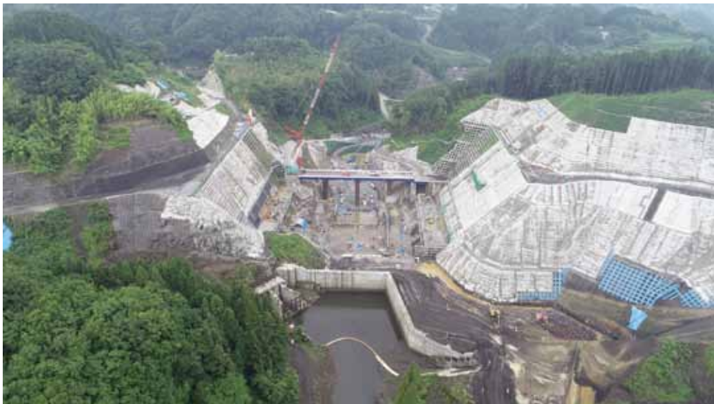
玉来ダム建設工事は、順調に進んでいます。今年の秋には難工事の放流設備工事が始まります。無事に施工できますように。
