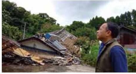
直入では、土砂崩れにより家屋が全壊。2名が家の下敷きに。竹田市消防署と三菱メディカルセンター DMAT等の救命救助活動で2名とも無事です。(7月8日)
